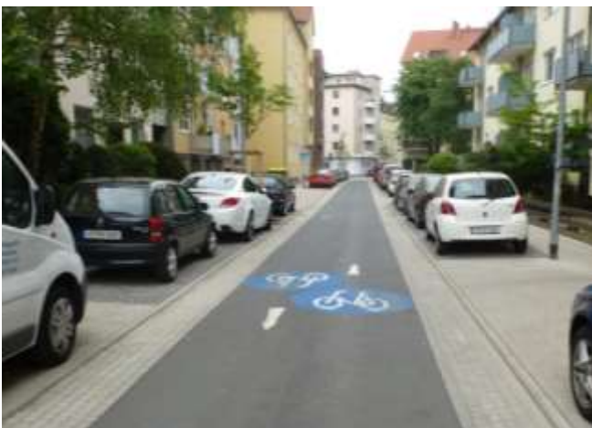
Bild 18 Baulich gestaltete Einbahn- und Fahrradstraße in Hannover
