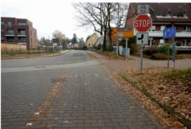
Knotenpunkte: Zahlreiche Knotenpunkte (hier Feldbehnstraße / Justus-von-Liebig-Ring) weisen Mängel in der Führung des Radverkehrs und deren Kennzeichnung auf. Vielfach entstehen dadurch Konfliktpotenziale und auch Sicherheitsdefizite.
