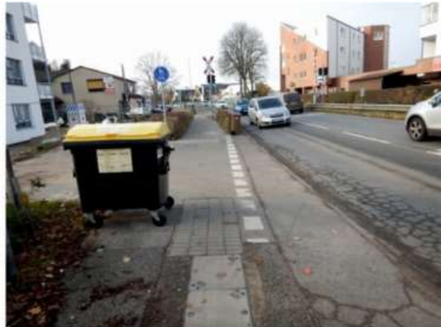
Bahnstraße: Durch Bahntrasse und hohe Kfz-Belegung geprägter Straßenraum mit schwieriger Verkehrsflächen-Aufteilung und deutlichen Defiziten in der Radführung inkl. Belagsmängeln.
