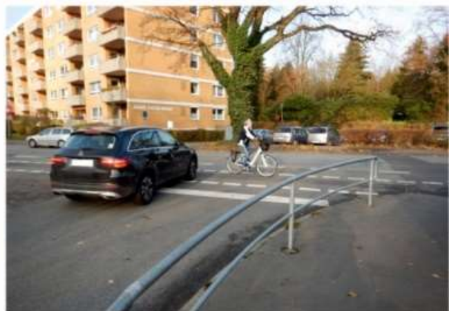
Ellerauer Straße: Wichtiger Schulweg mit hoher Kfz-Belegung und Konfliktpotenziale durch Zweirichtungs-Radführung sowie Defizite in der Gestaltung von Knotenpunkten und Überquerungsstellen
