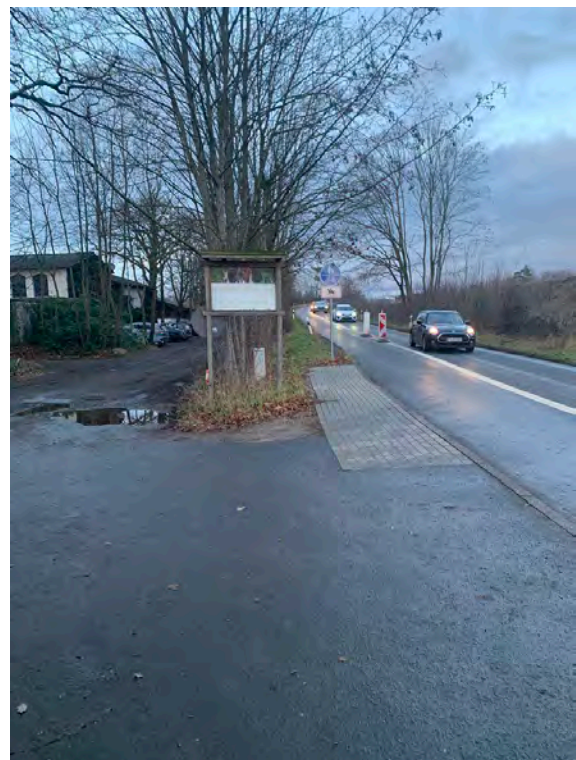
Abbildung 6: Rampe zum Brückenbauwerk über die BAB A7.
