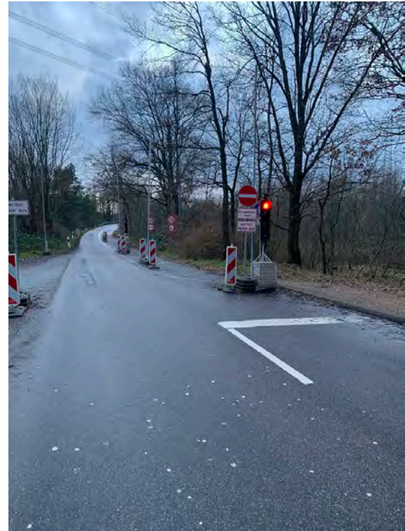
Abbildung 11: Ampelschaltung vor der Brücke und Radverkehrsführung Ost.
