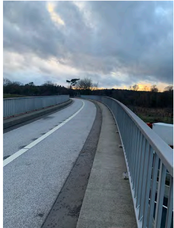
Abbildung 8: Fahrbahn der Brücke über die BAB A7
