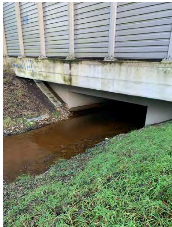
Abbildung 2: Durchlass der Gronau an der BAB A7.
