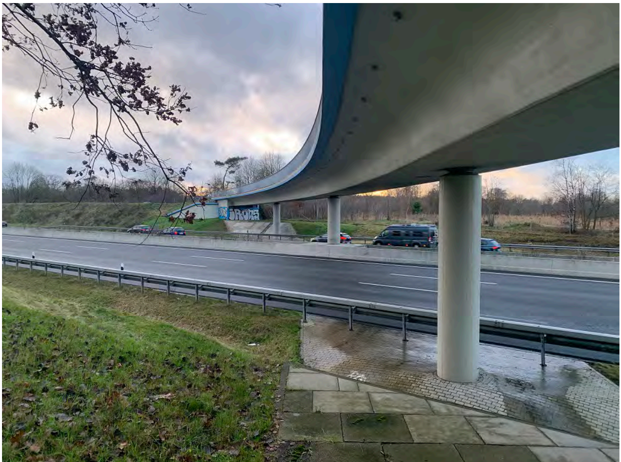
Abbildung 9: Tragkonstruktion des Brückenbauwerkes.
