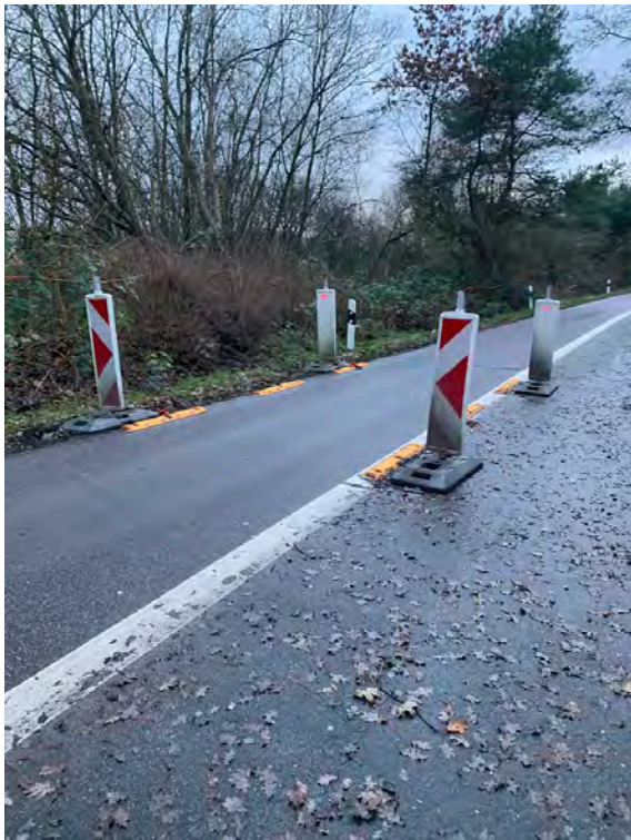
Abbildung 12: Breitenbegrenzung vor der Brücke.
