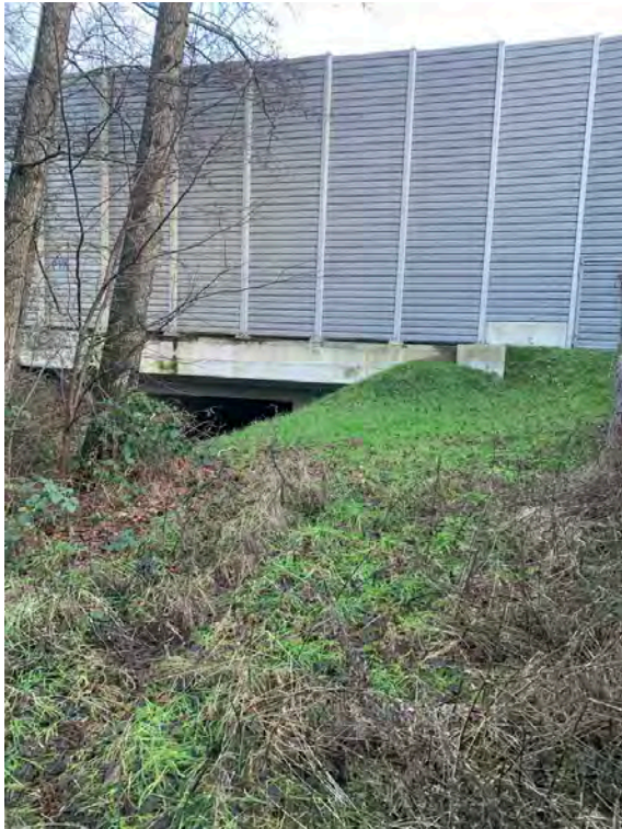
Abbildung 3: Lärmschutzwand im Bereich des Durchlasses.
