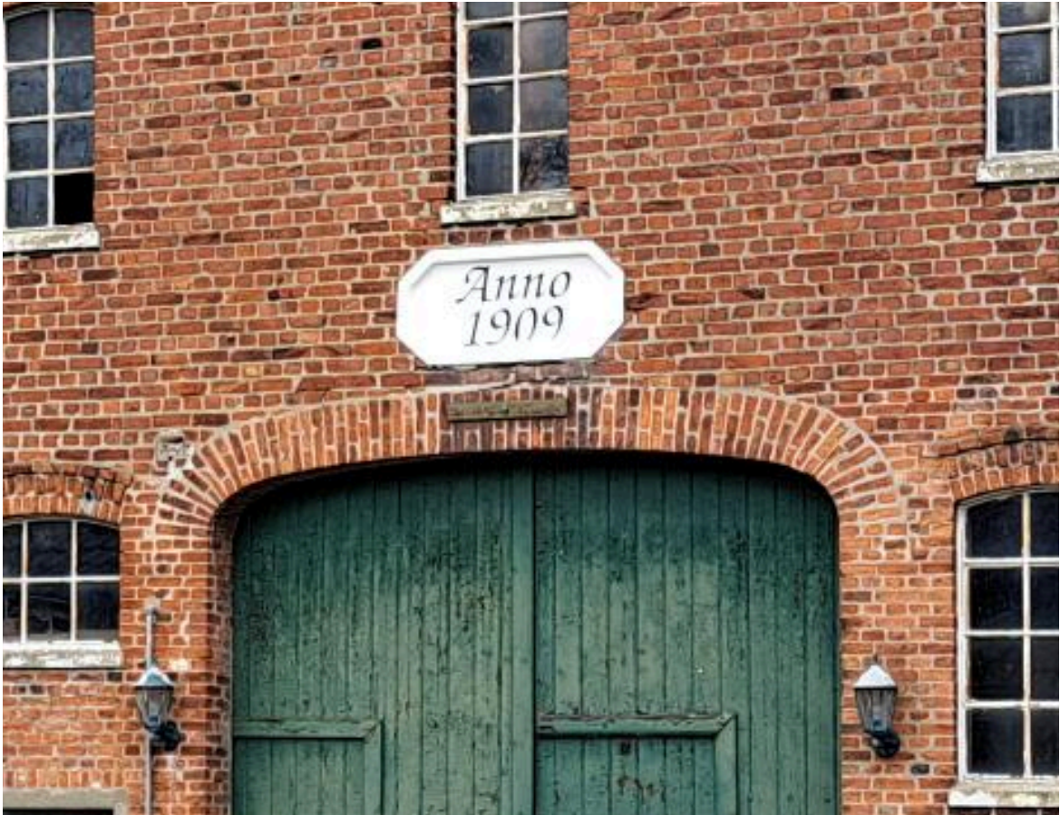
Die Scheune (einschließlich des Wohnhauses) an der Pinneberger Straße 20 wurde am 1909 von Jochim Ramcke, einem Bauern (1869-1946), gebaut.
