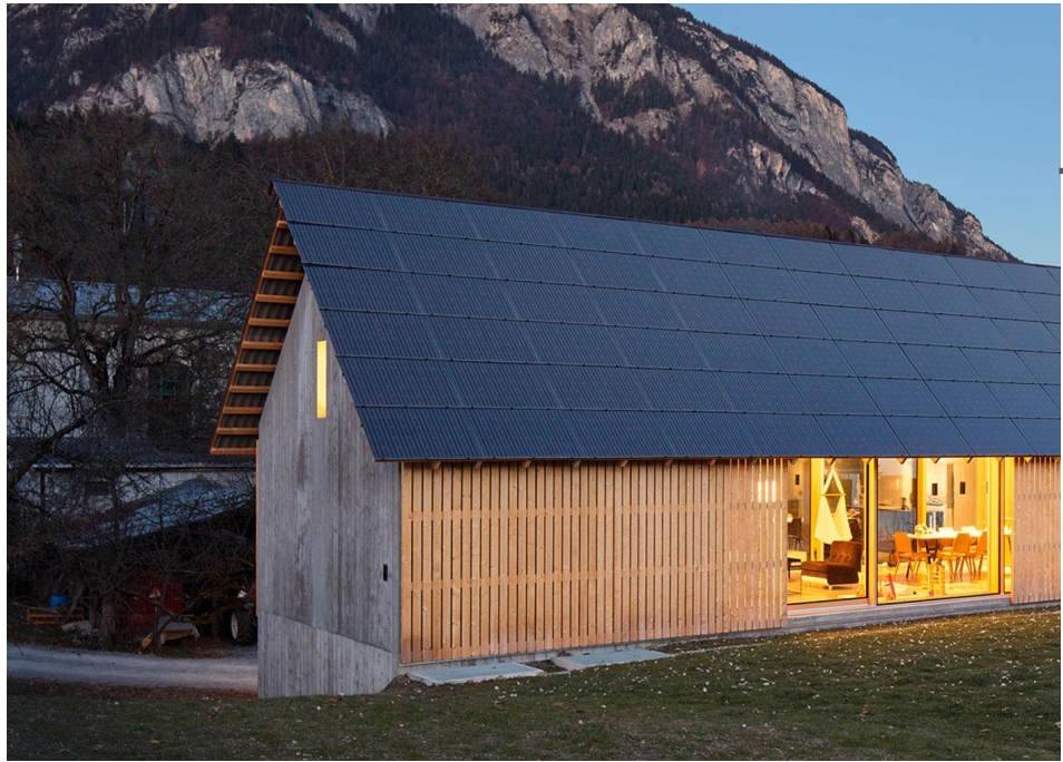
Photovoltaikanlage auf Schrägdächern
