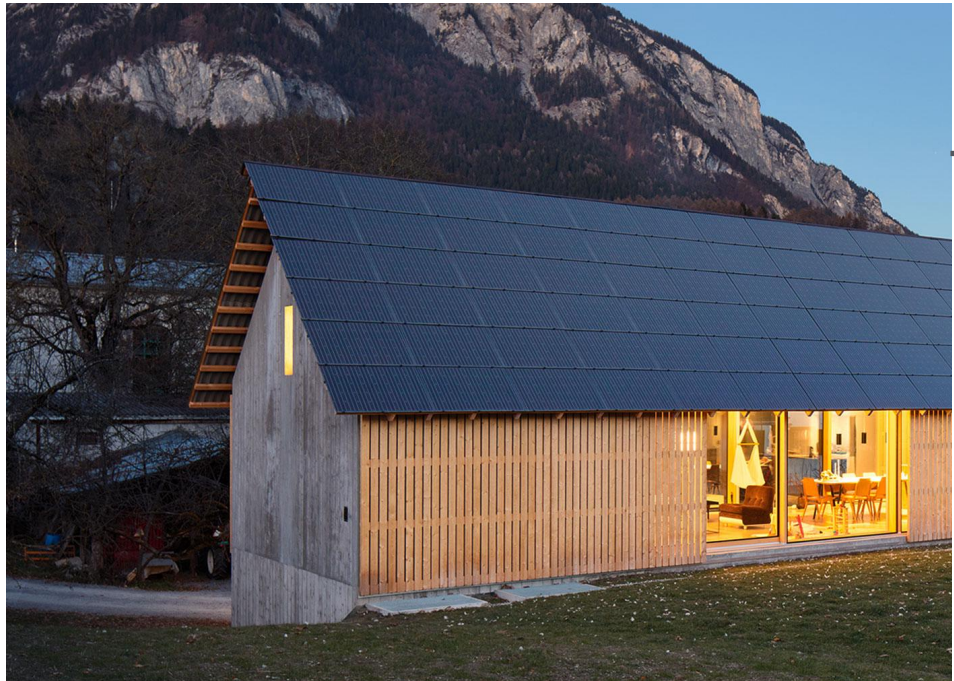
Photovoltaikanlage auf Schrägdächer
