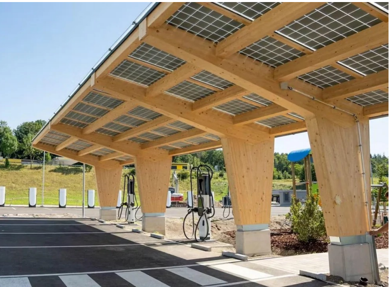
Photovoltaik Pergola für Parkplätze
