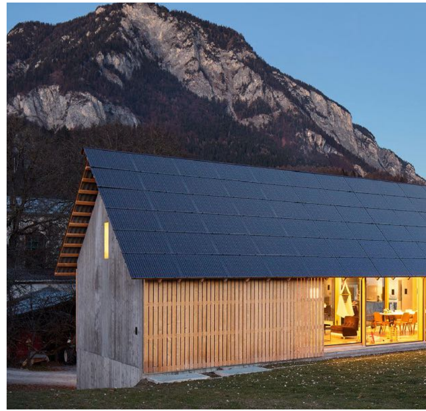
PV Anlagen auf Schrägdächern
