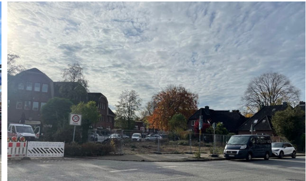
Baustelle auf Potentialgrundstück - Chance zur Anbindung Gerberstr. / westliche Bahnhofstr.
