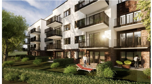
Blick nach Nordwest - Haus 2
