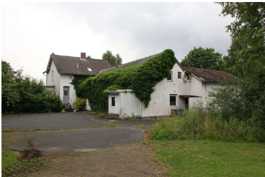
Abb. 2: Blick von Südost auf den südlichen Gebäudekomplex (Foto: 09.07.21)
