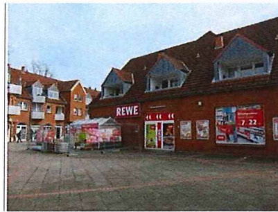
Bestehende Fassaden des Rewe-Marktes
