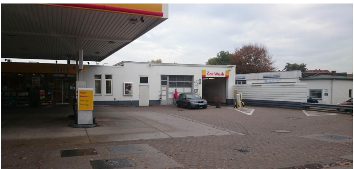
Blickrichtung Nordost auf Einfahrt Waschhalle mit Spritzschutzwand
