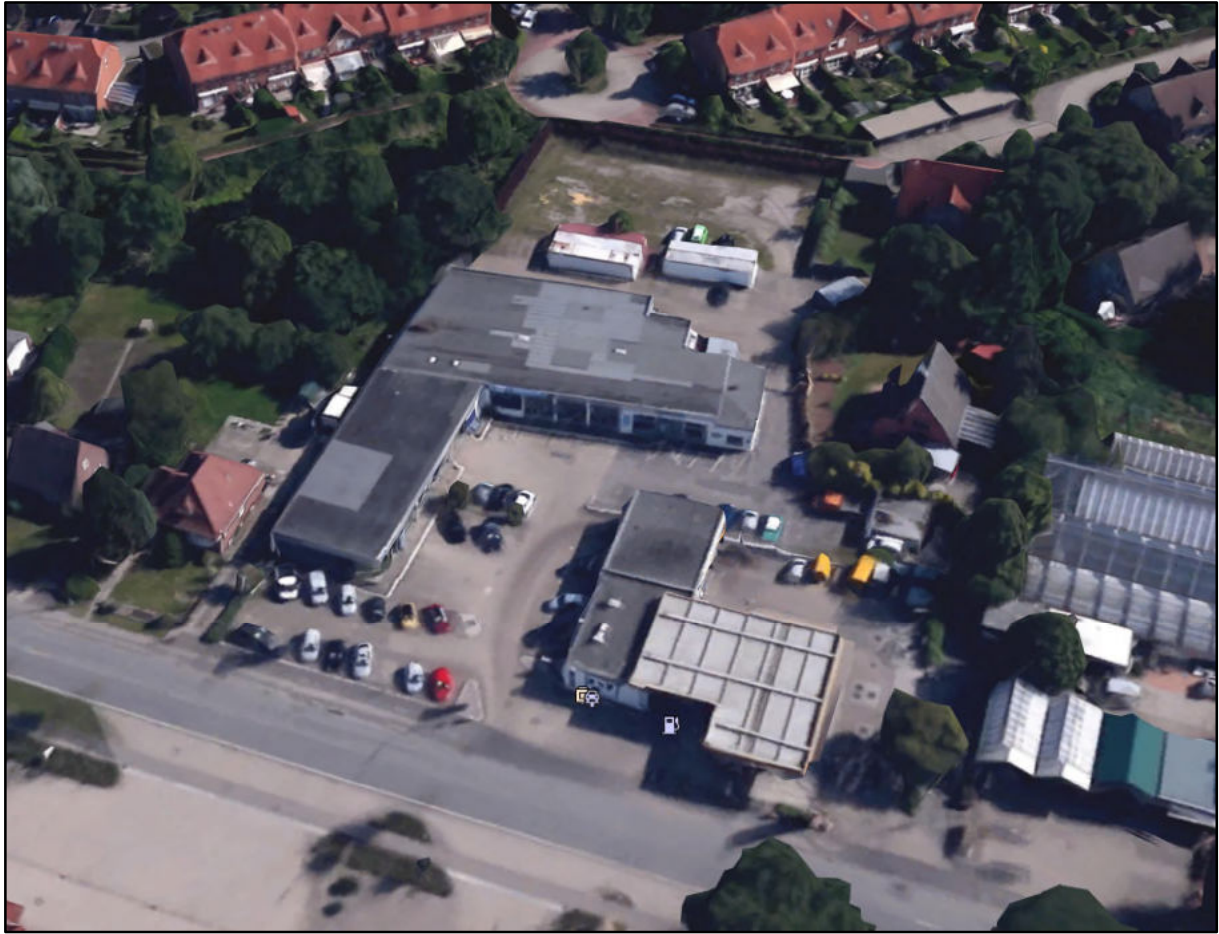
Abb. 7: Aktueller Zustand mit der Erweiterung durch die Flächen 68/132 und 68/133 im Jahr 1993 und 63/2 im Jahr 1987 zur Erweiterung der Tankstelle „Kieler Straße 70“ mit dem neu errichteten Wohnhaus an der Südostgrenze des Grundstücks
