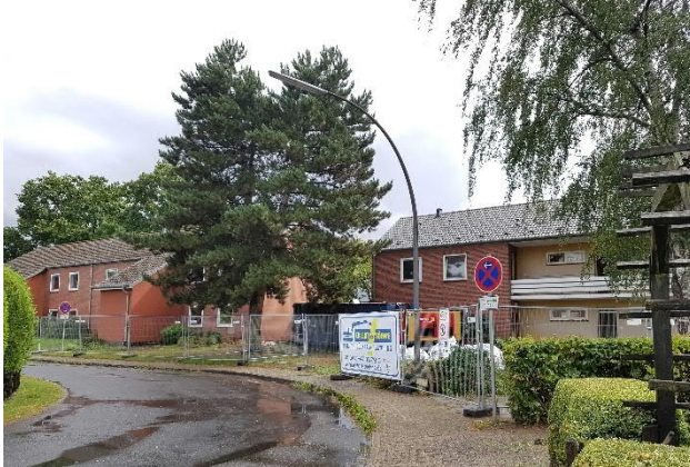
Abbildung 11 - Nordansicht der Bestandsgebäude
